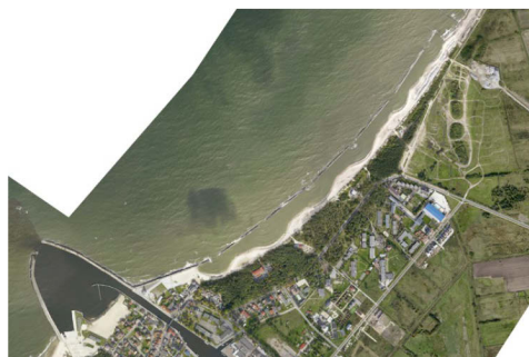
A. Przerwanie wzdłuż brzegowego potoku rumowiska, zatoka erozyjna
